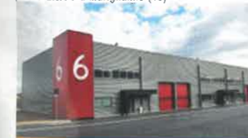
Construction d'un parc d'activités de 5 000 m 2 pour MEXITY à Marignanne (13)
