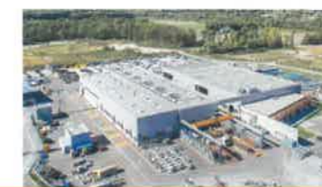
Construction d'une usine de 12 000 m 2 pour SAS - POMA à Gilly sur Isère (73)
