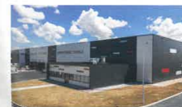
Construction d'un bâtiment industriel de 12 000 m 2 pour MONTEA - RENAULT à Meyzieu (69)
